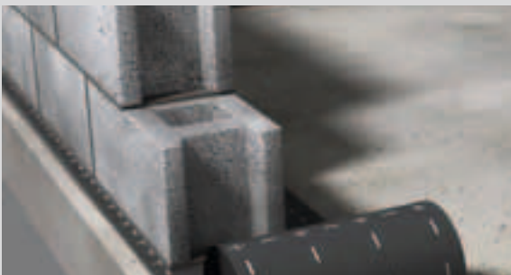
Beispiel Abdichtung gegen Bodenfeuchtigkeit unter erster Steinreihe
